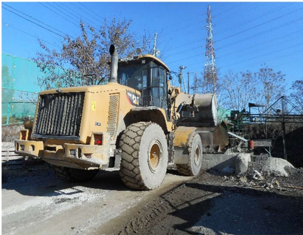
③ 投入ホッパーへ投入する
