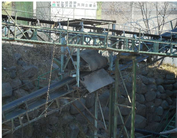
⑤ 磁選機により鉄筋を省きます
