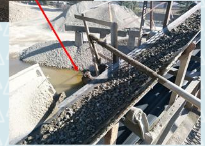
散水にて落ち口 粉塵対策
