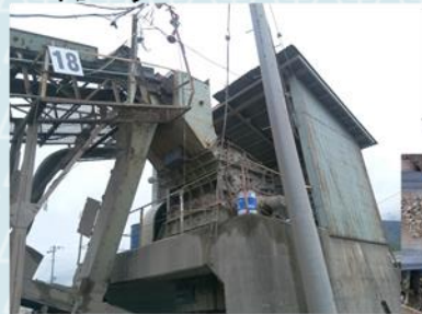
第三破碎機 インペラー
