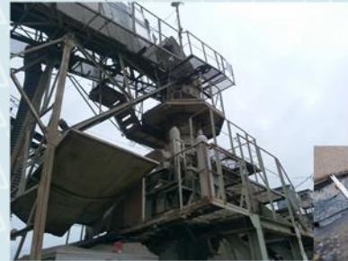
第二破碎機 コーンクラッシャー
